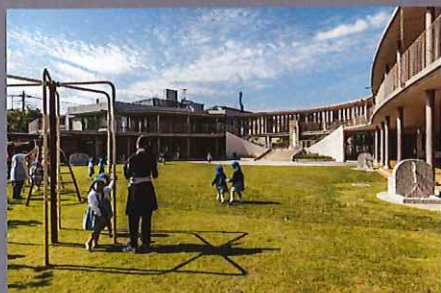
天然芝の中庭を囲むように配置された開口部の多い建築物
